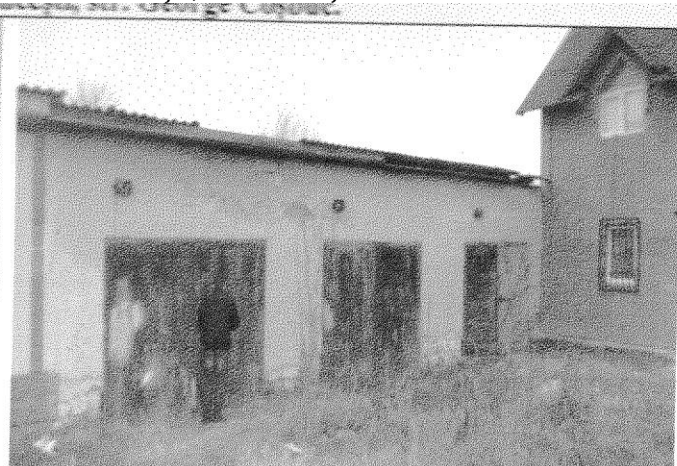
Construcție (garaj) cu terenul aferent (nr. cad. 5301204.1112.01, 5301204.1112)
