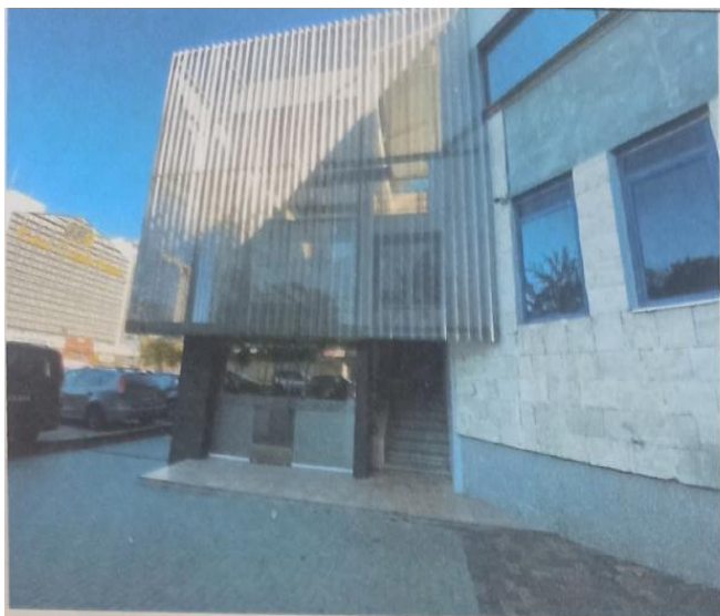
Accesul din stradă
